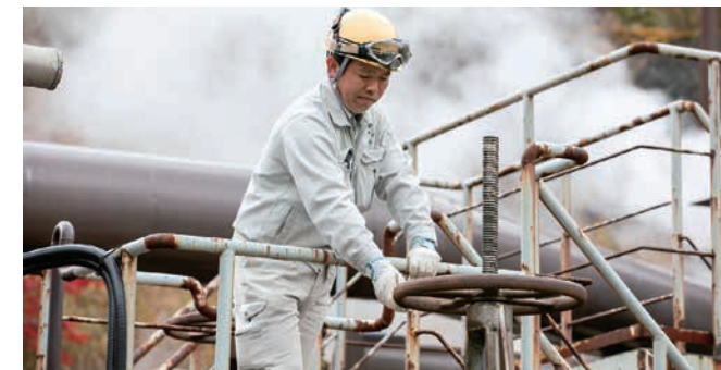
地熱発電所でのメンテナンス作業
